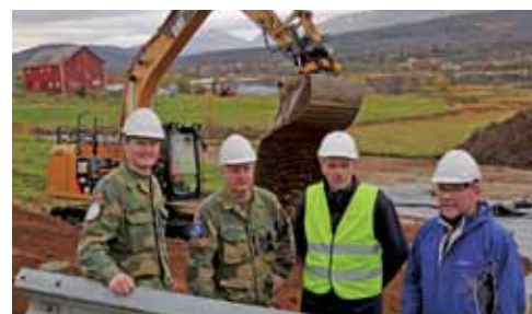
Grunnarbeidene for nye forsvarsboliger i Sørreisa er i gang. Ev. stabssjef Terje Johan-sen og sjef oberst Stig Johnny Haugen fra CRC Sørreisa, Kjell Heitmann, Forsvarsbygg og Arild Hau-gan, Aktør som bygger AS. (Foto: Arild Nordahl, Forsvarsbygg)
